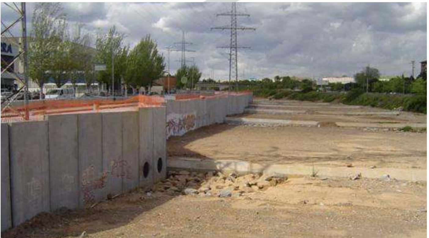
Canalización de una rambla en Cataluña con muro y estructuras transversales.
